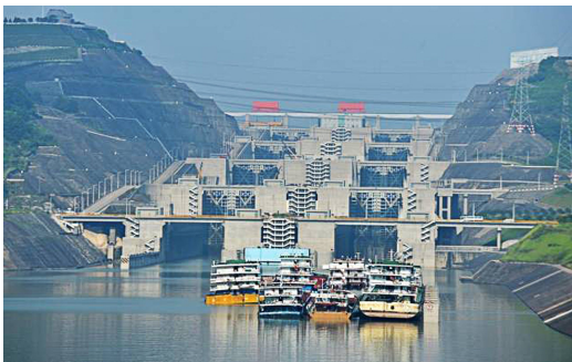
图1 三峡连续5级船闸
