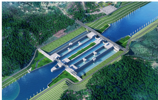
图2 平陆运河马道双线船闸(三级省水池)
