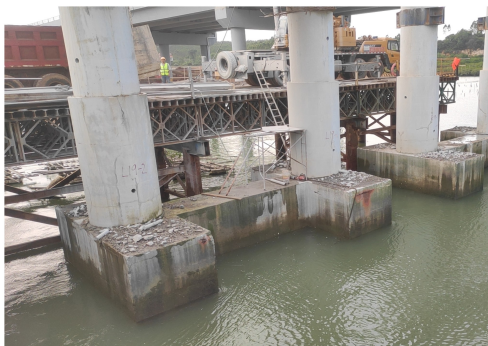
a) 废弃桥梁承台
