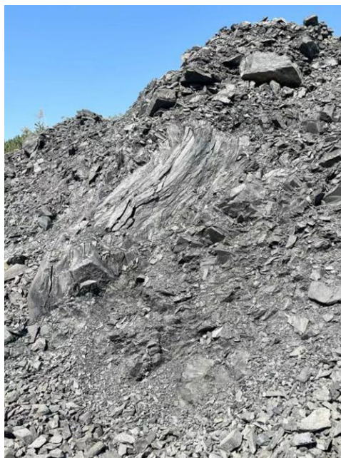
c) Ⅴ号边坡构造挤压带
