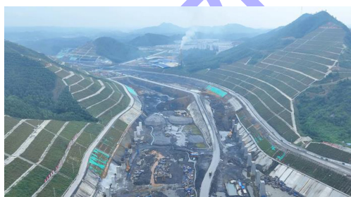
图 7 已建成 2 a 后的一期边坡
