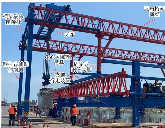
图 6 上部提升结构 Fig. 6 Upper lifting structure
