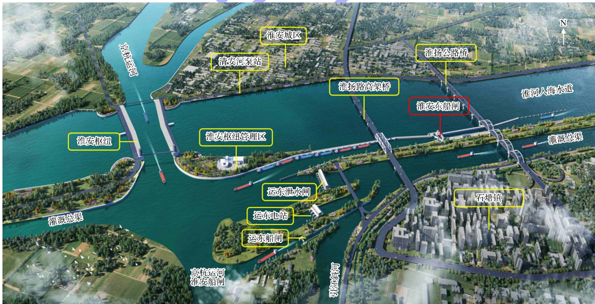
图 1 船闸周边建筑物
