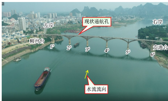
图 2 武宣大桥现状
