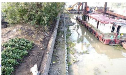
图5 调整后板桩轴线
