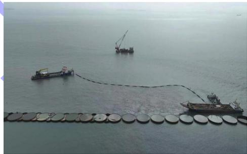
图 7 耙吸挖泥船船吹钢圆筒施工
