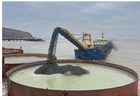
图 2 传统皮带船抛填钢圆筒
