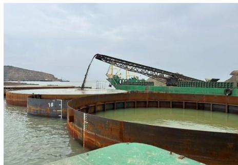
图 3 平板驳船改装后抛填钢圆筒
