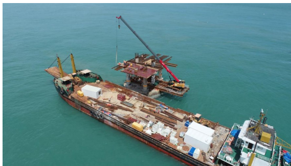
图5 履带吊吊装作业
