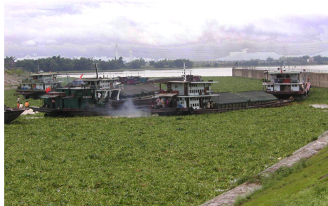
图 1 贵港一线船闸上游引航道漂浮物积聚情况
