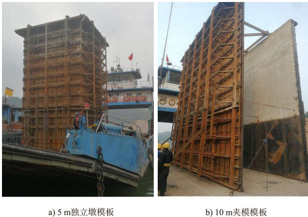
图 6 钢套箱模板
