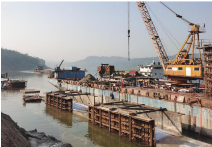
图2 挡墙浇筑
