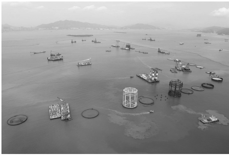
图2 香港口岸填海工程项目施工现场
