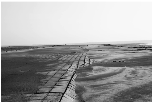
图4 H0#护滩带右缘X排区域淤积
