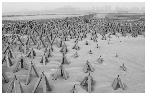
图 9 透水框架促淤带区域发生淤积
