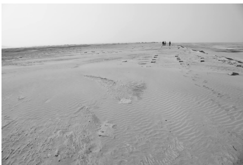
图 8 H1#护滩带加筋三维网垫淤积
