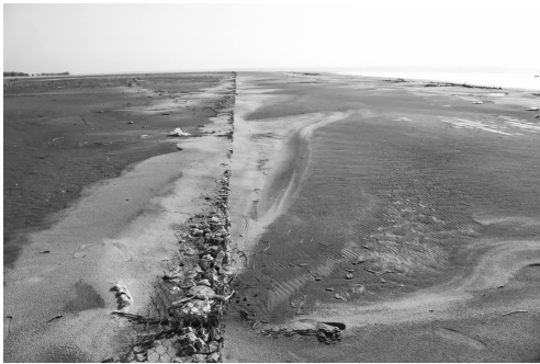
图 6 H1#护滩带钢丝网格淤积
