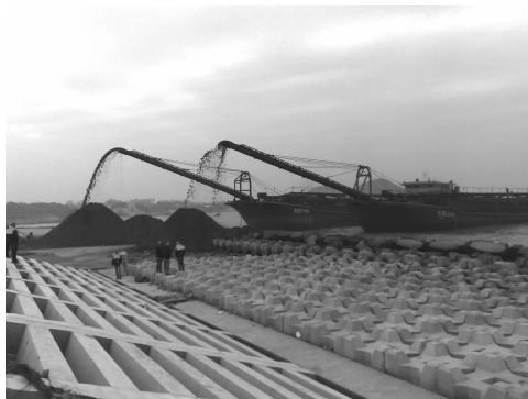
图 2 现场抛砂施工
