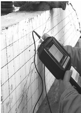
图 5 裂缝宽度测量
