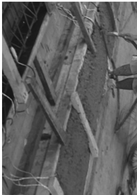
图 6 构件混凝土现场浇筑
