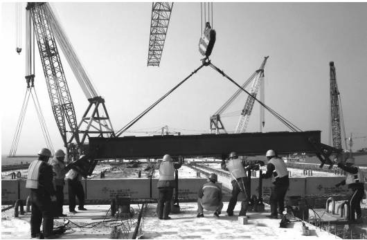
图 4 安装调梁扁担
