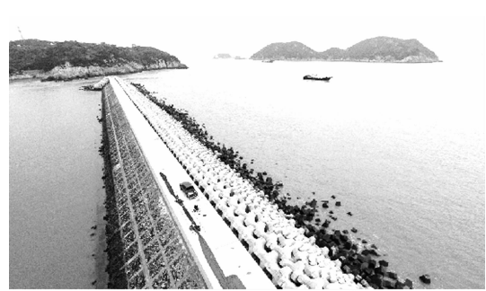
图 5 修复后的钓浜渔港防波堤
