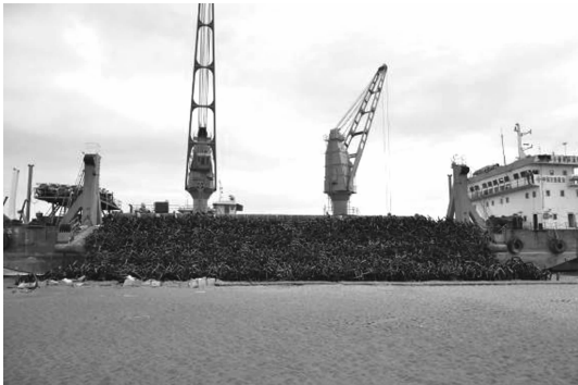
图 4 船机抛设主动式钩连体
