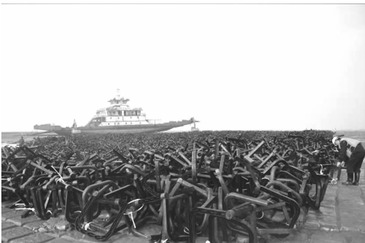
图 6 人工抛设主动式钩连体
