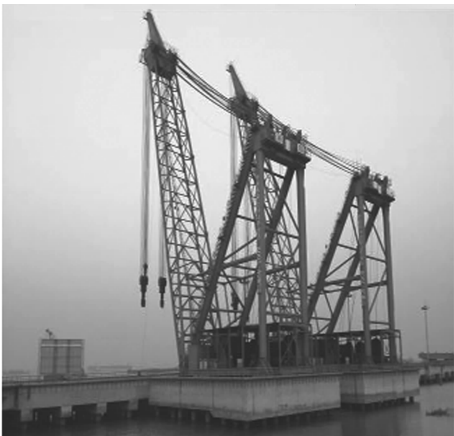
图 1 800 t 扒杆起重机及基础墩台
