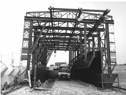
图 2 安装调试完成的模板
