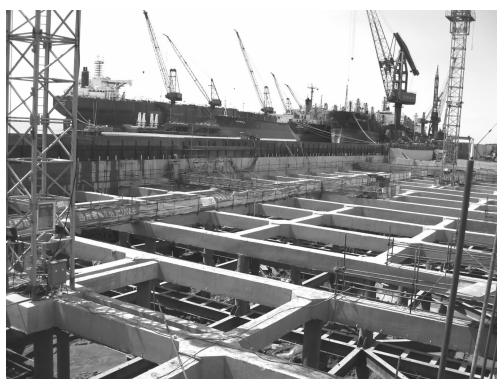
图 1 坞口基坑施工
