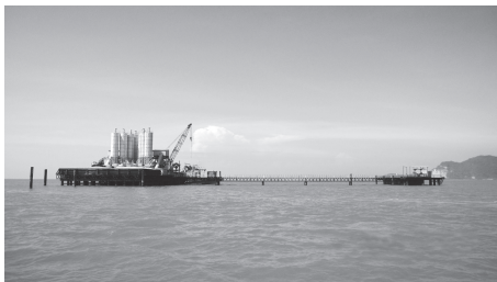
图5 主墩施工平台与边墩施工平台之间由钢栈桥连接
