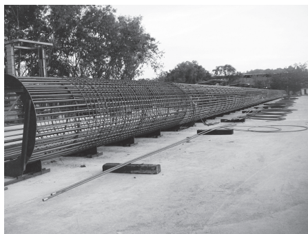
图4 钢筋笼长线法制作
