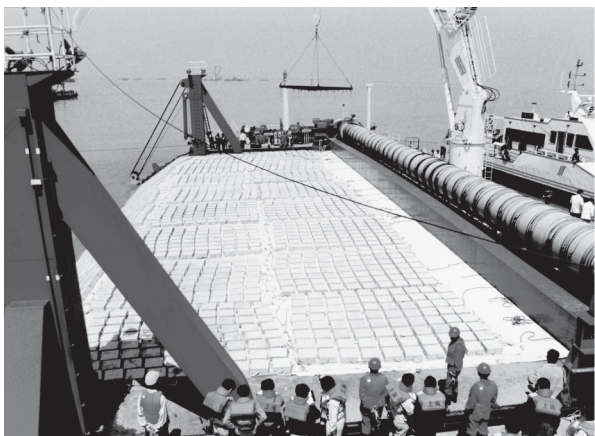
图8 专用软体排铺设船正在铺设混凝土联锁块软体排
