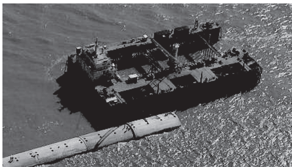
图9 半圆型沉箱安装船“安定1号”
