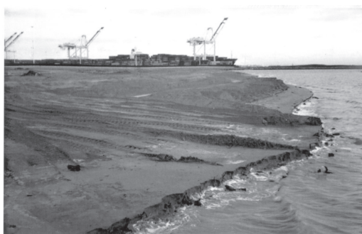
图8 奥克兰市海滨公园施工吹填过程
