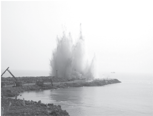
图2 阳江核电工程爆破挤淤法
