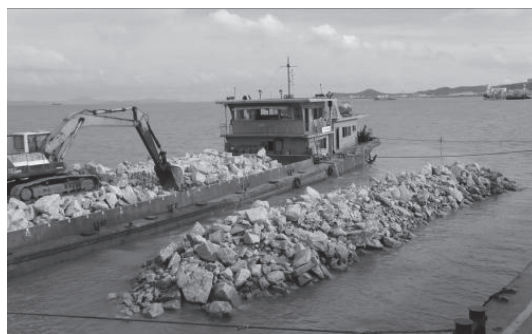
b) 船载挖机抛填
