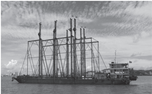
图11 港珠澳大桥珠海口岸人工岛填海工程水上插板船
