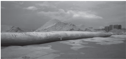
图5 港珠澳大桥珠澳口岸人工岛填海工程岛壁区砂袋围堰
