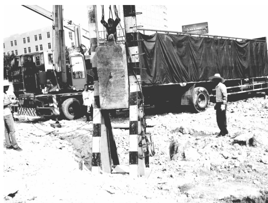
图 1 力传感器装在落锤上
