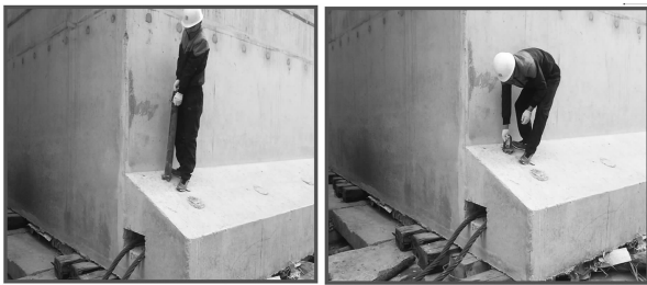
图1 “销轴”插拔施工
