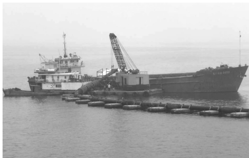
图4 艙吹装驳成功开挖
