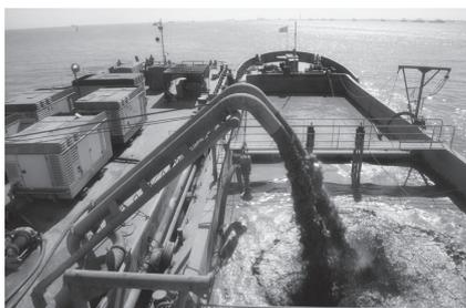
图1 无泥舱自航挖泥船（真如2<sup>#</sup>）施工作业
