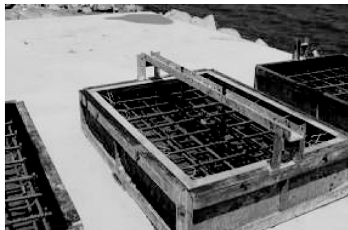
图3 吊点螺栓安装
