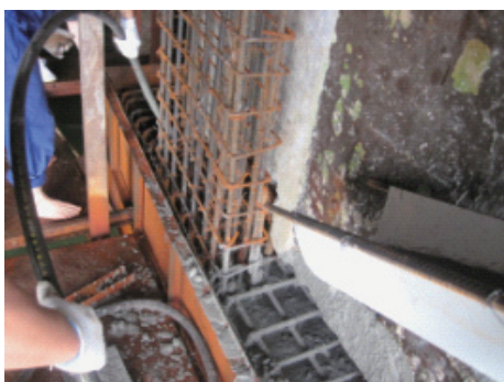
a) 桩帽混凝土浇筑
