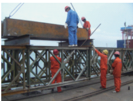
a) 吊装下搁置梁
