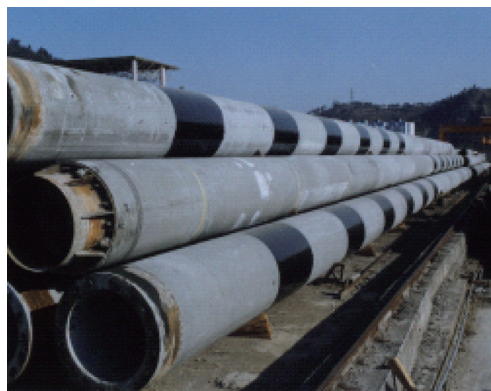
图3 大管桩接缝玻璃钢包覆
