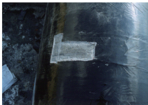
图4 包覆玻璃钢被敲铲后露出混凝土体
