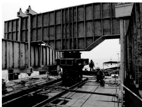
图1 压桩试验现场
