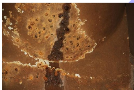
c) N-1反弧门下圆弧包板与门叶连接处
