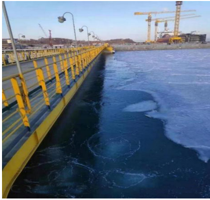
图 3 气泡防冻结系统实际运行情况
