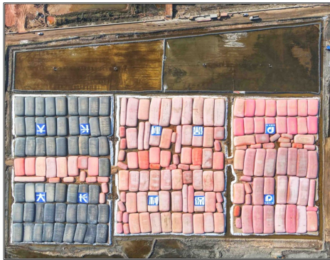
图 2 真空联合水袋堆载预压实景
