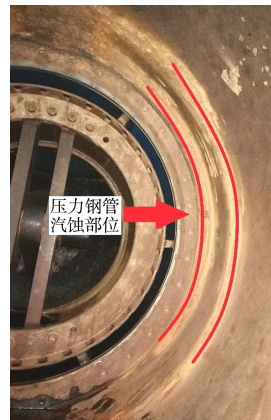
图 4 压力钢管汽蚀
