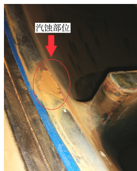
图 5 充泄水阀门汽蚀
