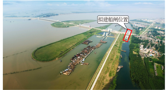
图 4 某船闸工程鸟瞰图
