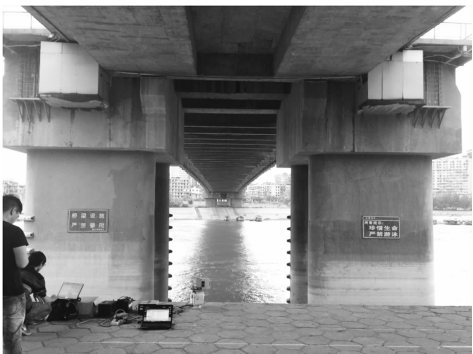
a) 桥墩现场
