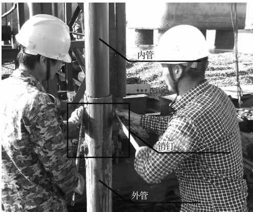
图 4 双层套管结构
