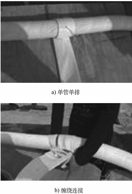
图 7 直排式水平排水系统
