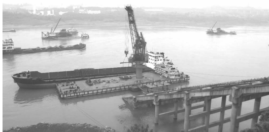
图 1 3 000 吨级多用途泊位架空斜坡道及趸船
