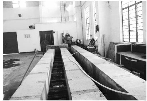
图 5 浇筑成型后的试验桩
