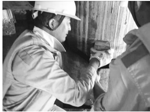
a) 安装混凝土激振块
