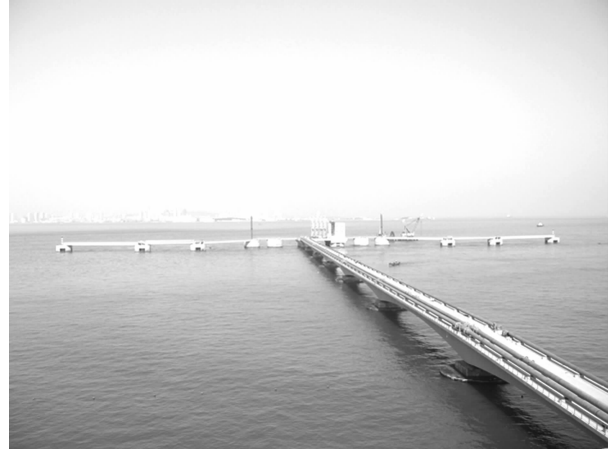
图4 变截面混凝土箱梁桥
