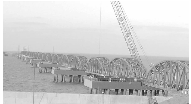
图6 拱桁式钢引桥
