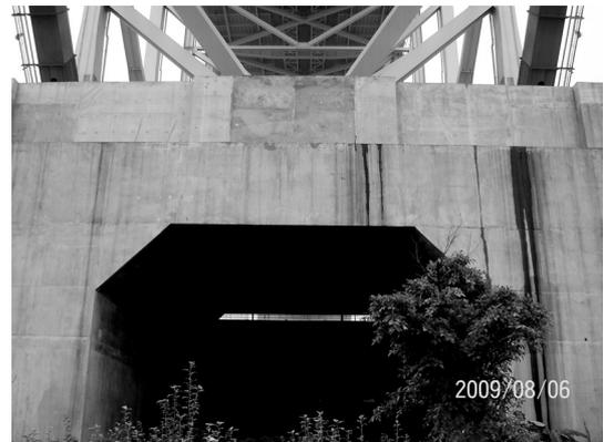
图3 主墩墩身顶预应力横梁连接
