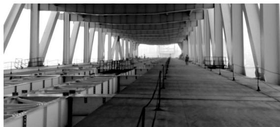
图7 正交异性钢桥面板(靠右)及纵横梁结构(靠左)
