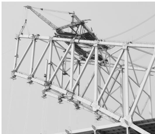
图8 作业中的架梁吊机
