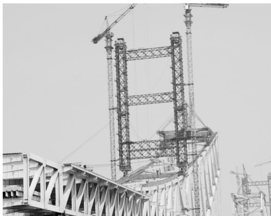
图9 正在安装临时扣塔
