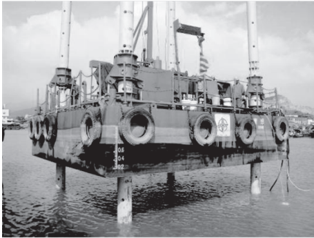
图2 海上液压升降钻探平台
