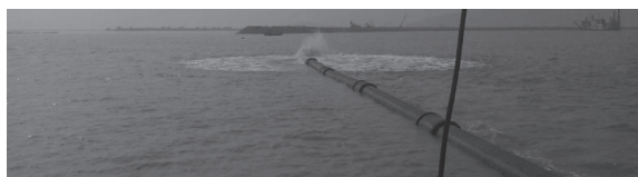
图7 沉管破损预设钢缆起吊打气维修
