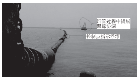
图4 水下排泥管线转向控制点示意
