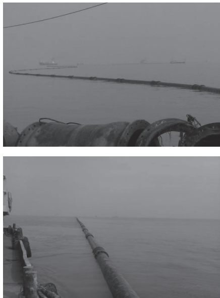
图3 拉直前后的水下排泥管线走向对比
