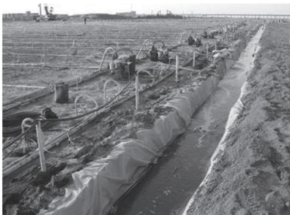
图2 真空降水管布置
