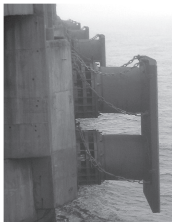
图4 安装后悬挑钢架和护舷
