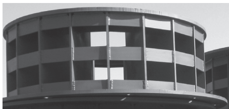
图11 焊接制作后的悬挑钢架
