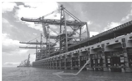
图5 建成投产的阳逻武钢码头
